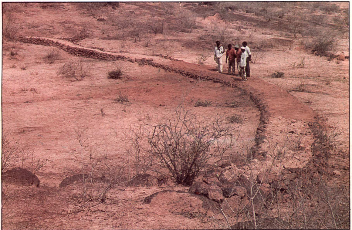
Fig.4 : Diguette de retenue d'eau en terre battue renforcée par des pierres pour l'abreuvement du bétail (SODEVA)
