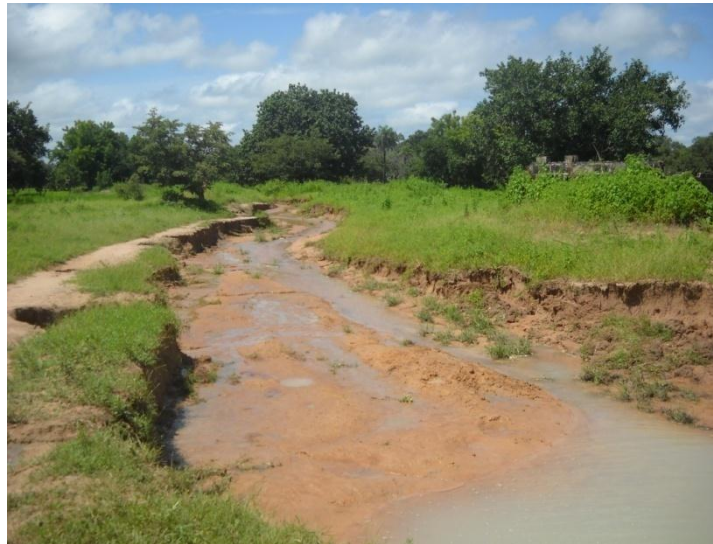
Photo 01 : érosion hydrique zone Samine Santo (Imblang Diédhiou, 2012)
