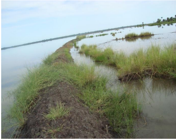
photo 10 : digue anti-sel de Bémet avec une présence de graminées rampantes qui montrent un début de dessalement des rizières (Imblang Diédhiou 2012).
