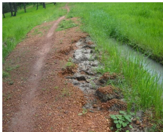
photo 03 et 04 : digue érodée et cassée zone Samine Santo (Imblang Diédhiou 2012)
